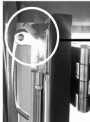
حرکت لولایی چفت به کمک دستگیره جهت قفل یا آزاد کردن ضامن
